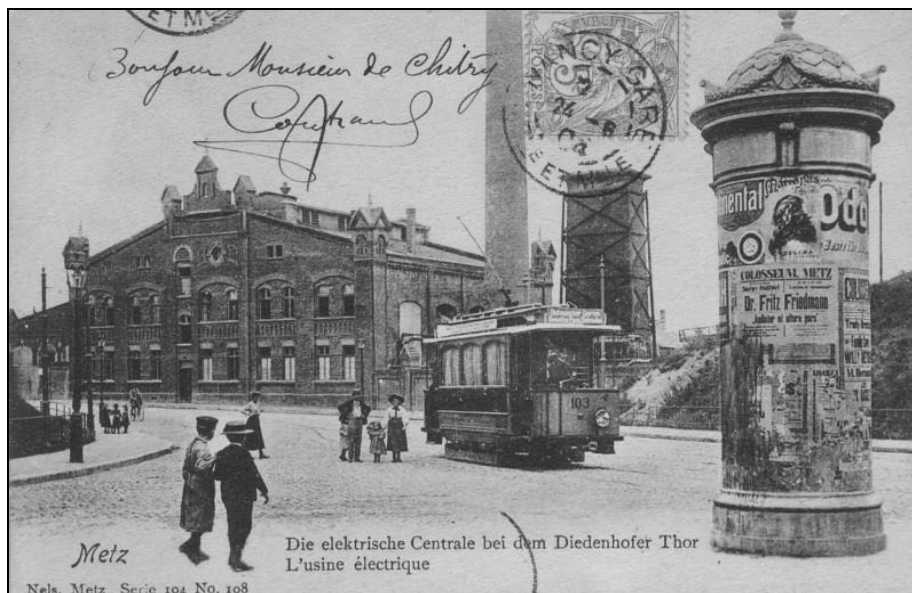
La centrale électrique du Pontiffroy.
